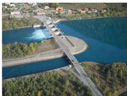
Pour procéder au décolmatage du lit de la Durance, une ouverture progressive et maîtrisée des vannes du barrage d'Espinasses va être réalisée par les exploitants d'EDF. Le débit de la Durance jusqu'à la retenue de la Saulce va alors graduellement augmenter passant de 4,1 m<sup>3</sup>/s à 40 m<sup>3</sup>/s, pendant 8 h environ.
