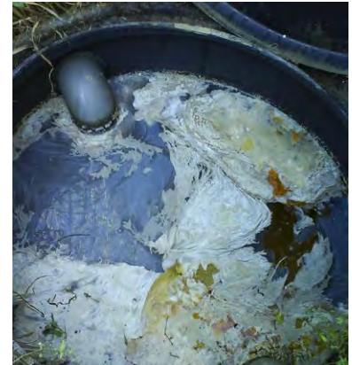
Figure 7. Croûte de graisses se formant en surface dans un bac dégraisseur
